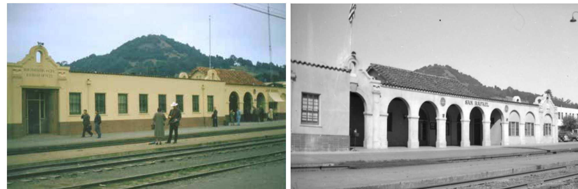
Later railroad era -- east side of the building with renovations/additions Últimos días del ferrocarril -- lado este del edificio con renovaciones/adiciones
